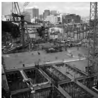
서울 산학협력관 및 기숙사 현장 전경
