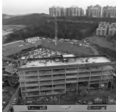
일산 종합강의동 및 약학관 현장 전경
