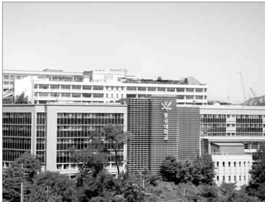
▲ 패러다임 전환으로 인한 혼돈의 미래사회를 대비해 중장기적 대책을 마련해야한다.
