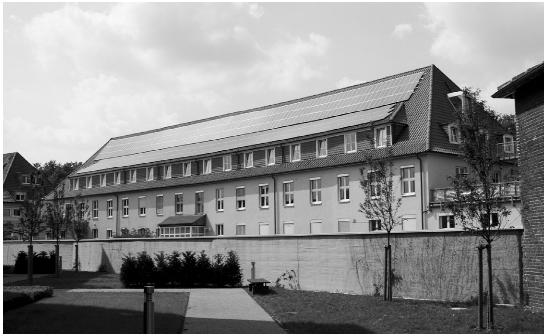
▲ 윈스터 대학 지붕 위에 설치되어 있는 태양열 집광판
