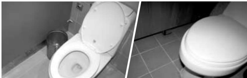
화장실 개보수 공사를 통해 학림관 화장실(왼쪽) 바닥 칸막이를 설치했다. 오른쪽은 바닥 칸막이가 없는 학생회관 화장실.
