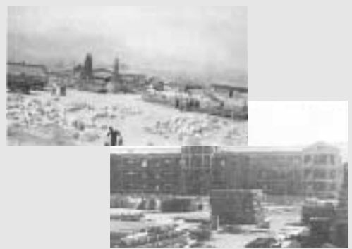
건설 공사중인 대학 본관(현 명진관)
