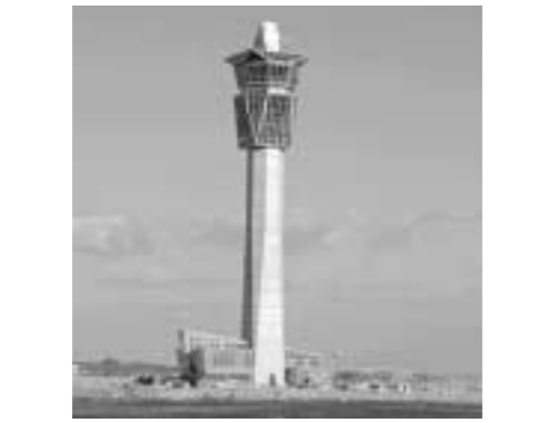
그림 2. 진동제어시스템이 설치된 인천공항 관제탑
