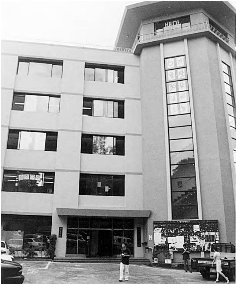
'기능성' 새단장 ... 하계방학 중 학생회관 외벽공사가 진행됐다. 이번 공사는 건물 내부가 여름에 시원하고 겨울에 따뜻하게 유지될 수 있도록 하는 '드라이 비트' 공법을 이용했다. 김진성 기자 yeam@dongguk.edu
