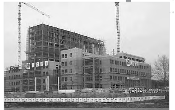
불교종합병원 ... 불교종합병원이 지난 99년 공사를 시작한지 약 1년 만에 전체적인 형태를 드러냈다. 약 30%정도 완료된 병원 공사는 현재 12층까지 철골공사를 모두 마쳤고 건물 외장공사와 내부 미장, 배관공사를 진행중이다.
