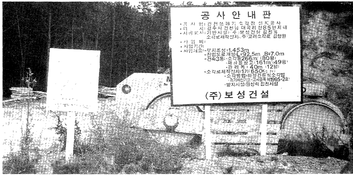
사진은 건천을 대곡리 쓰레기 소각장 설치 공사현장
